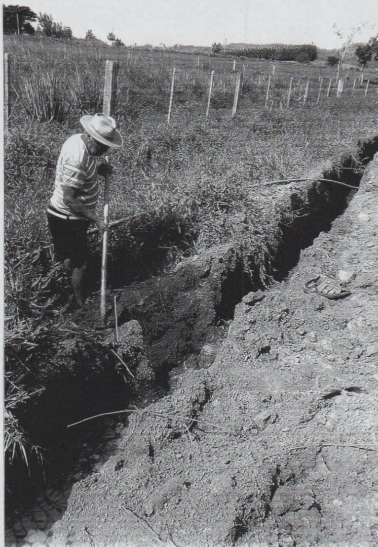
Detalhe da comunidade auxiliando nos trabalhos de encanamento
