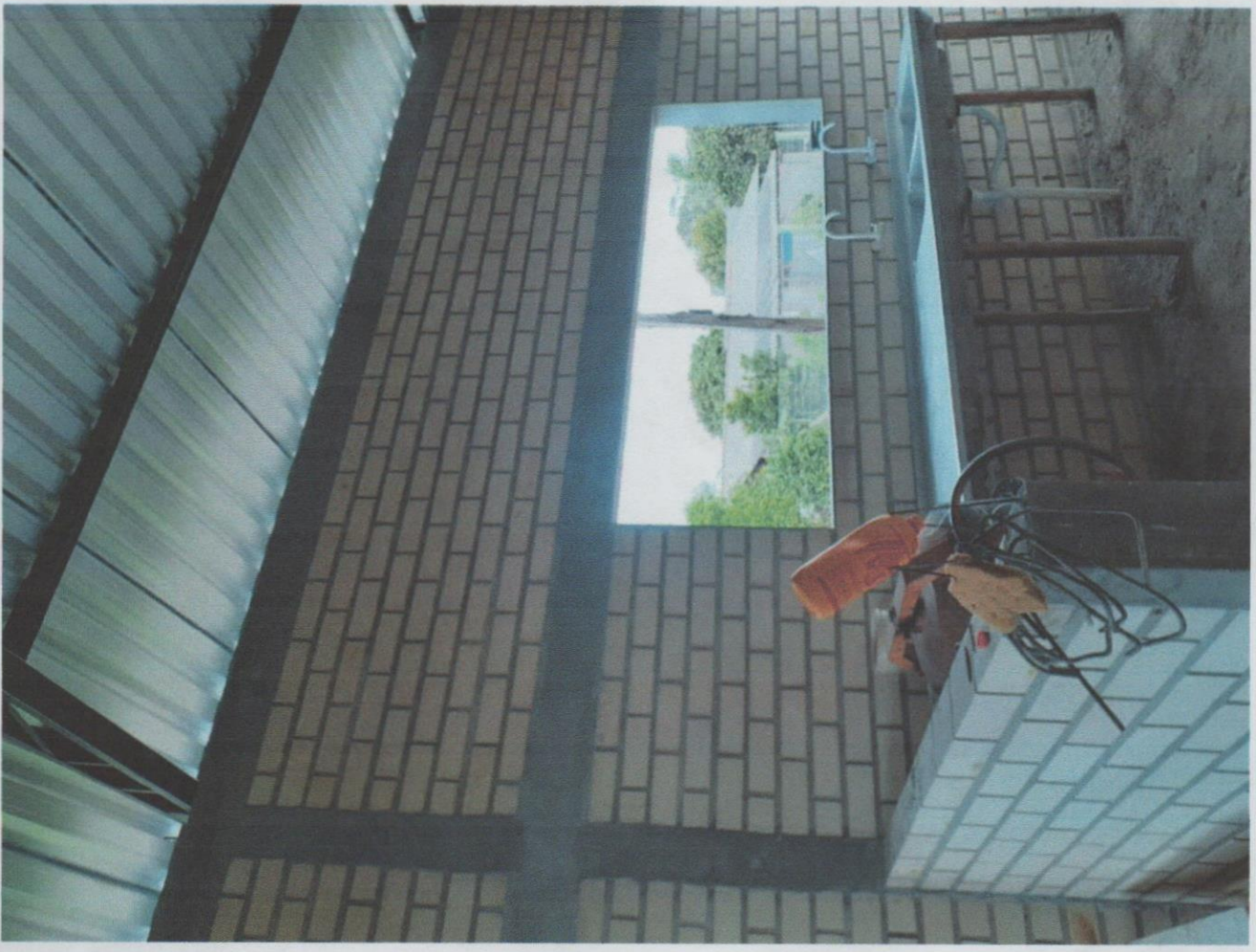
TELHADO DA COZINHA
