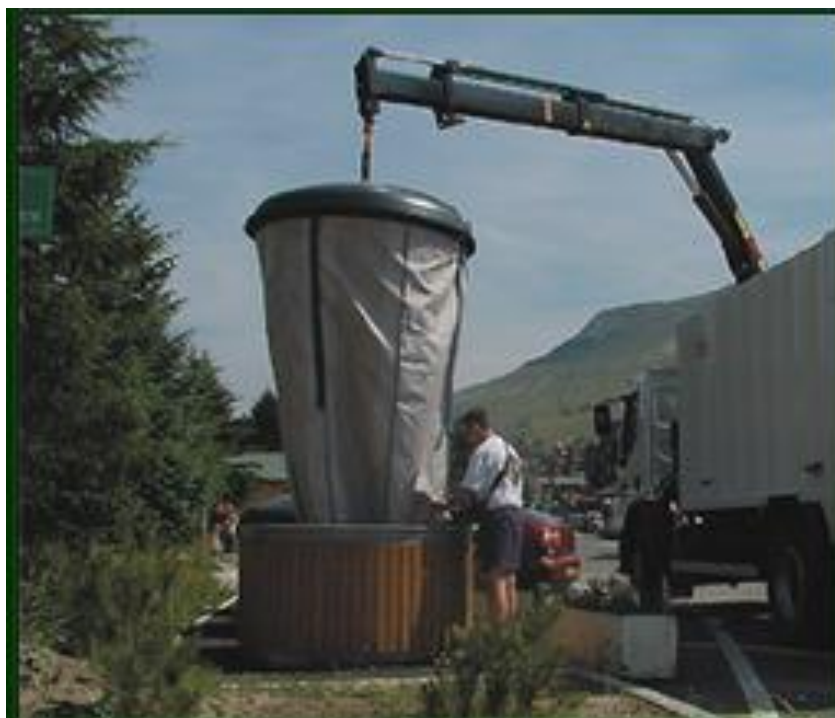
Figura 15: Recolhimento dos resíduos.
