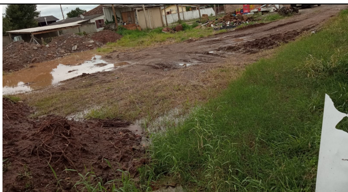
Foto 7: Terreno dos fundos, com aterro sendo executado. Área destinada a instalação de brinquedos.
