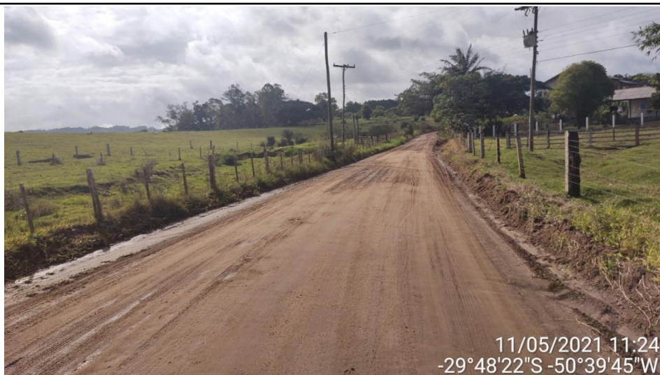
Foto 5: Vista geral do trecho - Estaca 60
