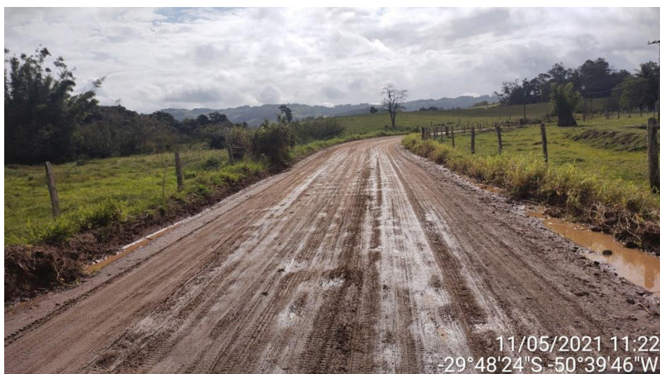
Foto 4: Vista geral do trecho - Estaca 55
