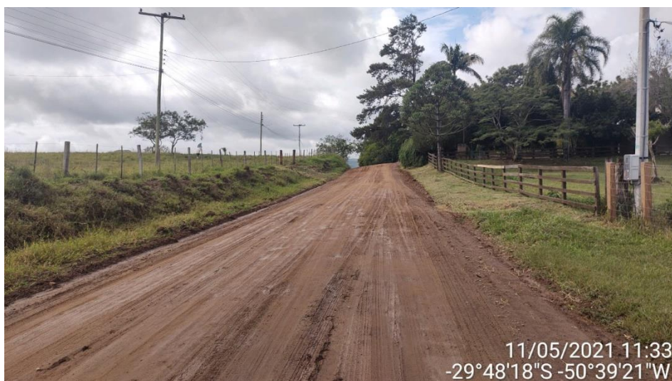
Foto 12: Vista geral do trecho - Estaca 95
