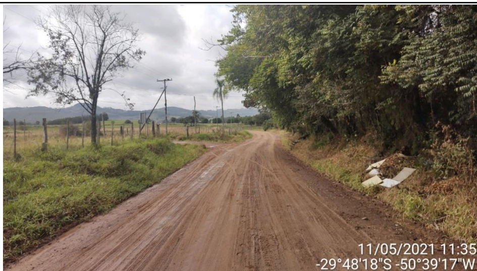
Foto 13: Vista geral do trecho - Estaca 100
