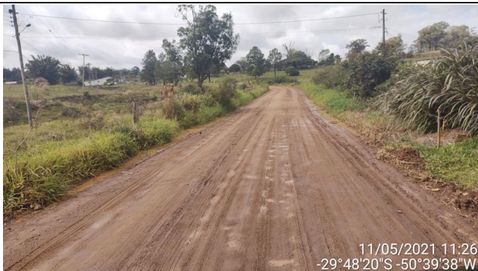
Foto 7: Vista geral do trecho - Estaca 72
