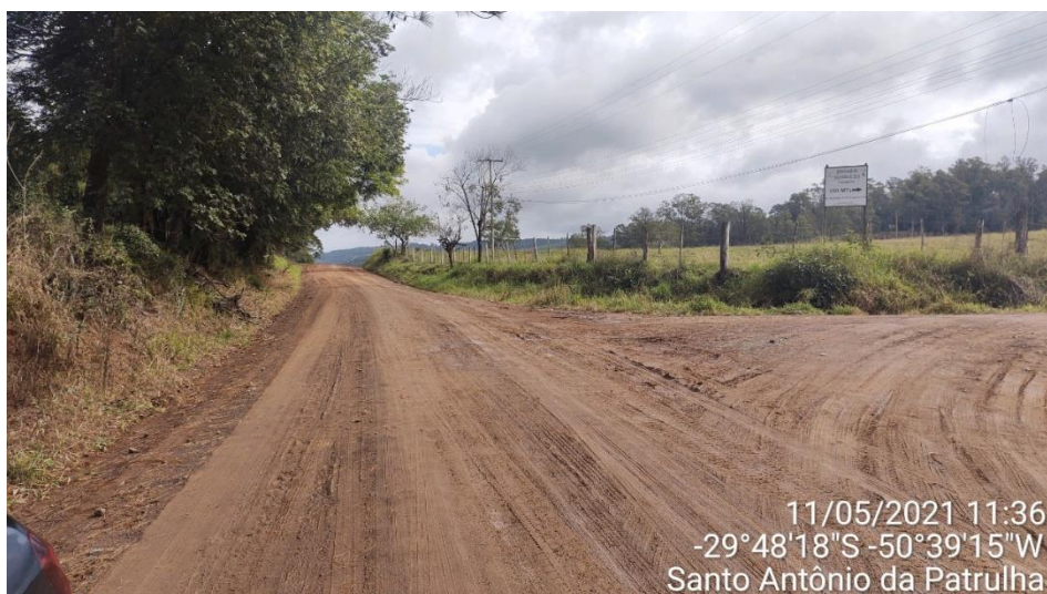
Foto 14: Final do trecho - Estaca 103+4,00m
